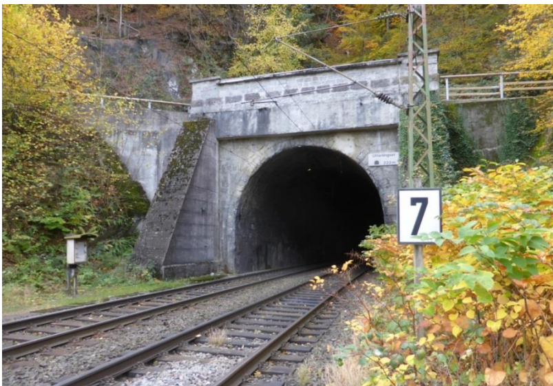
Abb. 23: Blick auf den 222 m langen Ütterlingser Tunnel
