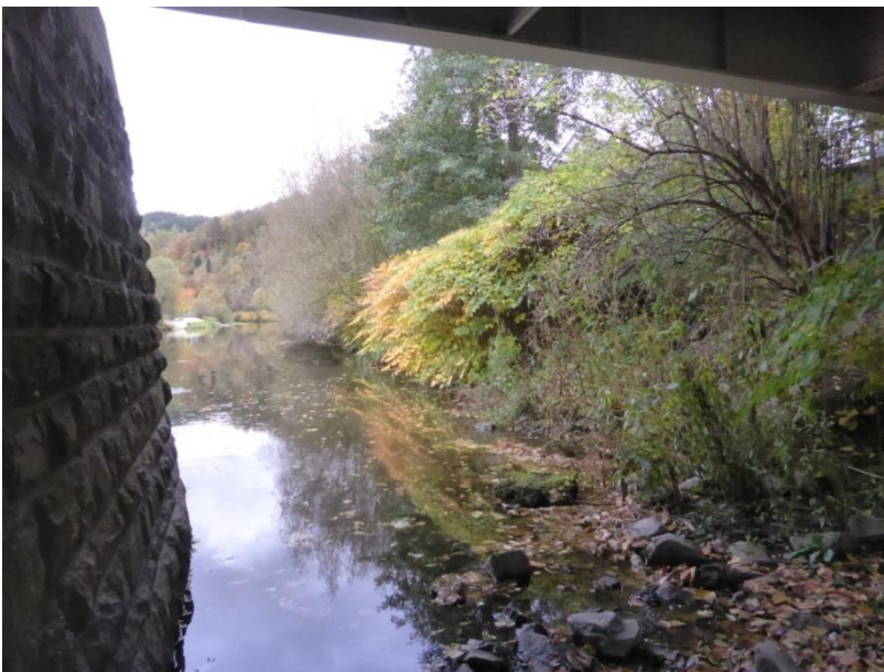
Abb. 26: Blick auf das Lenneufer am geplanten Lennnebalkon
