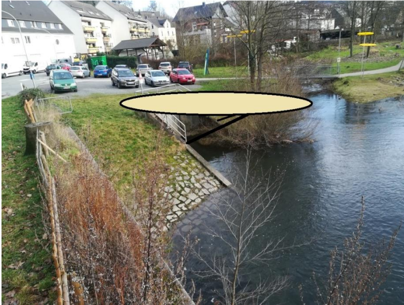
Abb. 12: Lenne-Deck über dem Einlaufbauwerk an der Soppemündung
