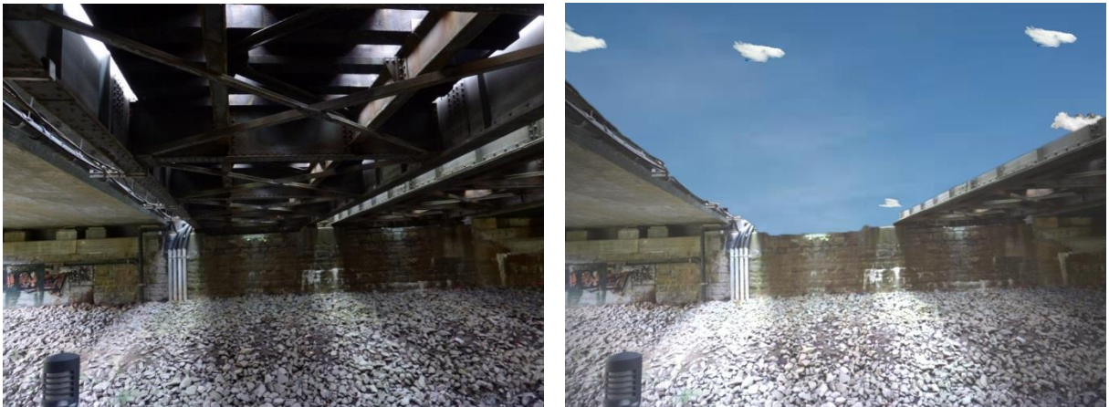
Abb. 10: Das tote Gleis der Bahnbrücke an der Vosslohstraße von unten
