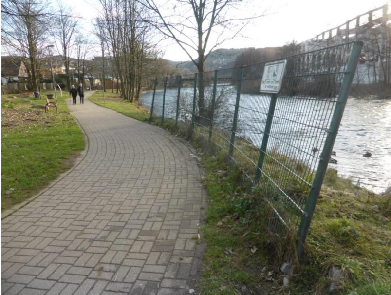
Abb. 11: Statt des Stabgitterzauns ist hier die Lenneböschung mit einer Schnitthecke zu sichern
